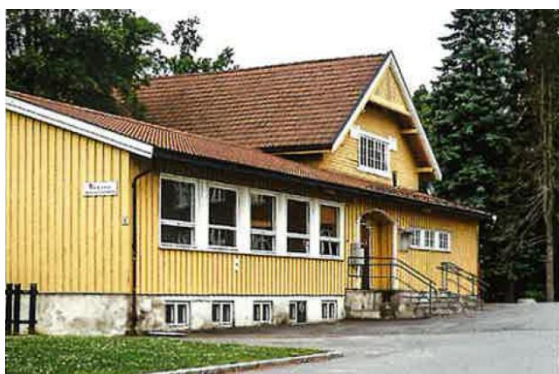
Midtgard ungdomshus. Tidligere sløyd- og gymsal på Åsgård skole. Revet 2021 (Foto: Nikolai Bjørneby, 2010)
