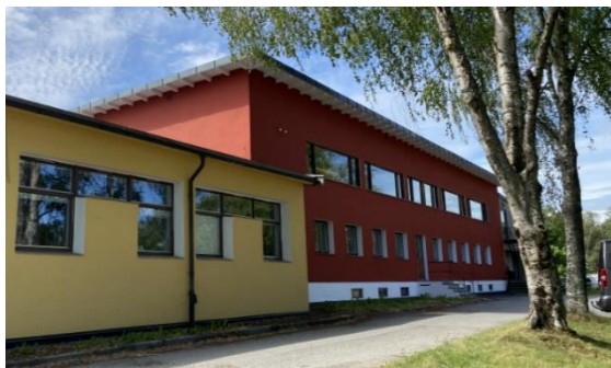
Samfunnsbygningen fra 1934, (foto: Kjersti Sørli Rimer)
