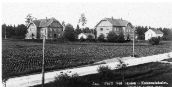
Åsgård og Ås skole, bygget i 1913/14. (foto: Åkla/Normann forlag.
