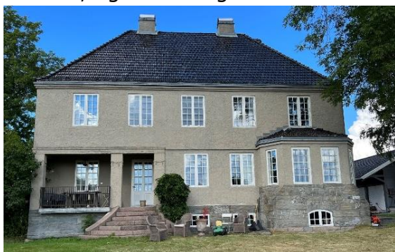
Hovedbygningen på Nedre Holstad gård fra 1915 oppført i stilarten nordisk nybarokk (foto: Carl F. Høeg, 2022)
