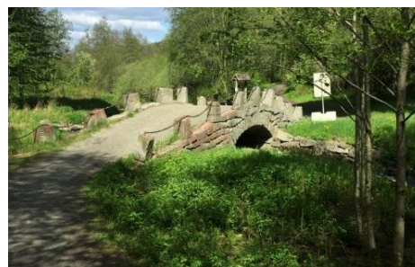
Gamle Kongevei. Dalsbro over Dalsbekken mellom Nordre Follo og Ås. Steinvelvsbroen ble gjenreist av Statens vegvesen ca. 1990 (foto: Carl F. Høeg, 2022).
