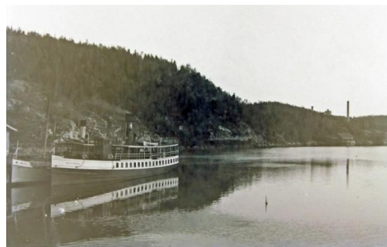
Bekk teglverk innerst i Bunnefjorden - de to pipene i bakgrunnen og lagerskuret, 1920-tallet (foto: ÅKLA/H.P. Bjørnstad)
