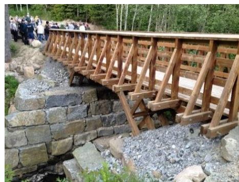
En nybygd Bølstad bro på de gamle brokarene gjenåpnes i 2012 (foto: Carl F. Høeg)
