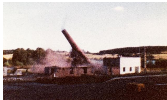
Pipa på Holstad teglverk rives i 1981 (foto: ÅKLA)
