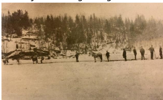
Isdrift ved Feylingdammen, ca 1900 (foto: utlånt fra Ingar Jonassen)
