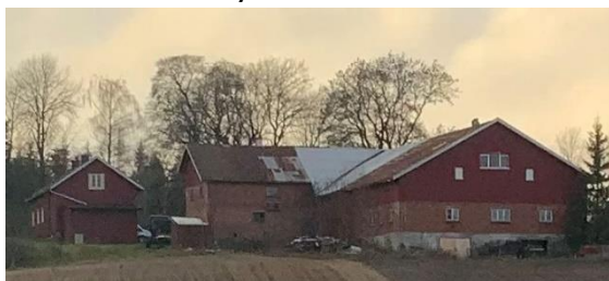
Søndre Slørstad gård, driftsbygninger (foto: Martin Løken, 2022)
