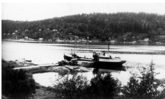
Båt laster dynamitt ved Kjærnes brygge på 1950-tallet (Foto: ÅKLA)
