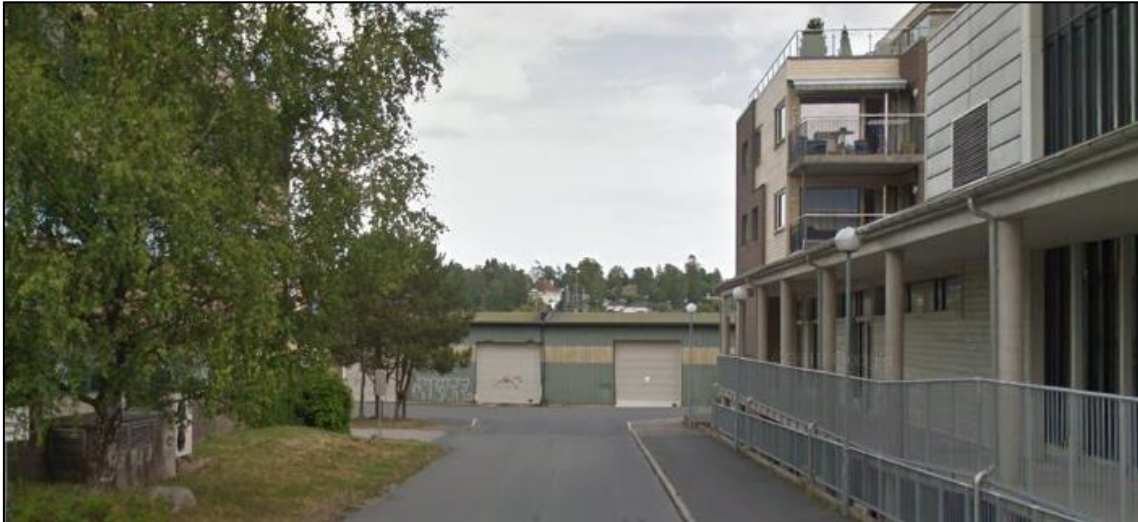
Figur 6 Tverrforbindelse mellom Brekkeveien og Moerveien på sydsiden av planområdet (bilde: Google Street View)
