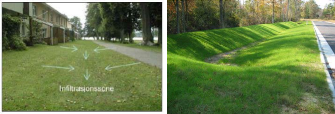
Eksempel på infiltrasjonssone og gresskleddede grøfter. Foto: Gøran Lundgren og Sveinn T. Thorolfsson/T. Leidstedt (Kilde: Prinsippnotat VA og overvann).
