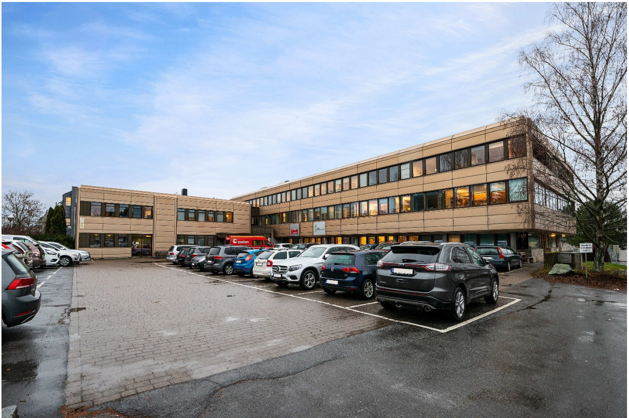
Bebyggelsen sett fra Moerveien (sørvest).
