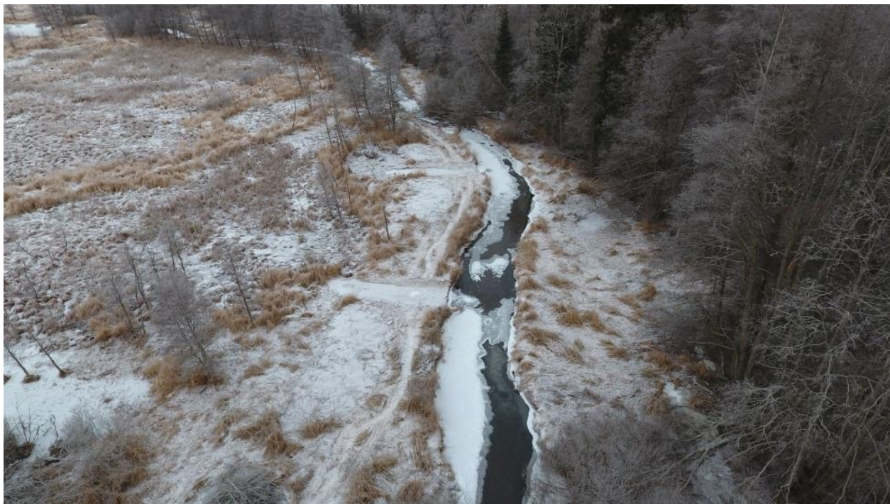
Figur 7: Nye flomkanaler i Dalsbekken 2018. Foto: Oppegård, Ås og Ski kommune.
