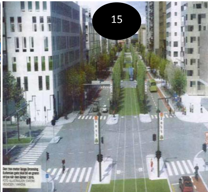
Fig.14. Den nye Dronning Eufhemias gata bak operaen i Oslo er 42 meter bred, mer enn det dobbelte av vanlige bygater. Overvannshåndteringen inklusive flomvei er en viktig del av utbyggingen. Illustrasjon: Statens Vegvesen/Vianova
