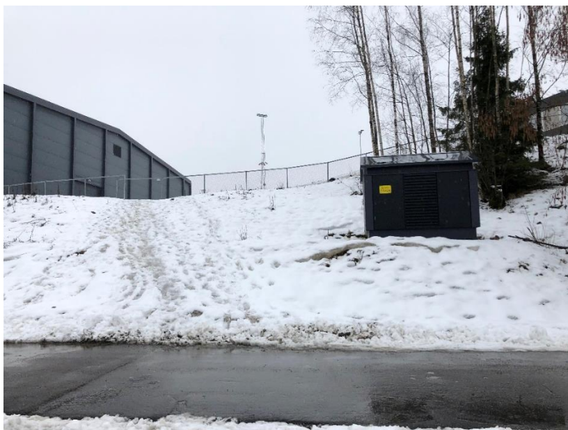
Figur 43 Trase for snarveien, sett fra Langbakken. Teknisk bygg til høyre i bildet
