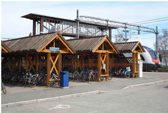
Figur 3.24 Sykkelparkering ved stasjonen i Ås.
