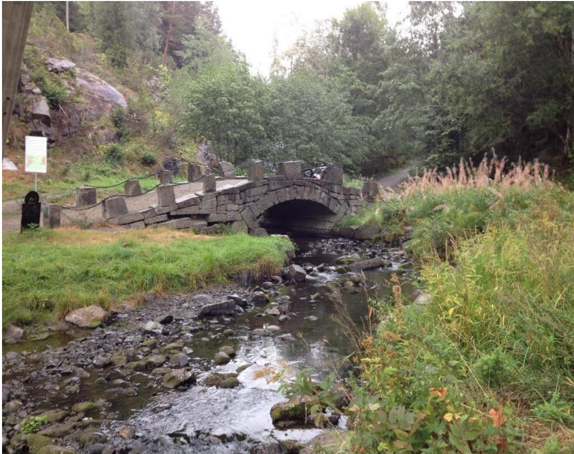
Figur 12: Steinhvelvsbrua over Dalsbekken. Foto: Ås, Ski og Oppegård kommune.
